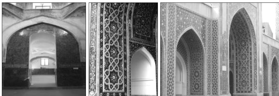
تصویر ۱۲. کاشی کاری معرق ایوان ورودی تصویر ۱۳. کاشی کاری تصویر ۱۴. کاشی کاری فضای زیرین گنبدخانه (بختیاری، ۱۳۹۲) معرق بدنه ایوان (بختیاری، ۱۳۹۲)
