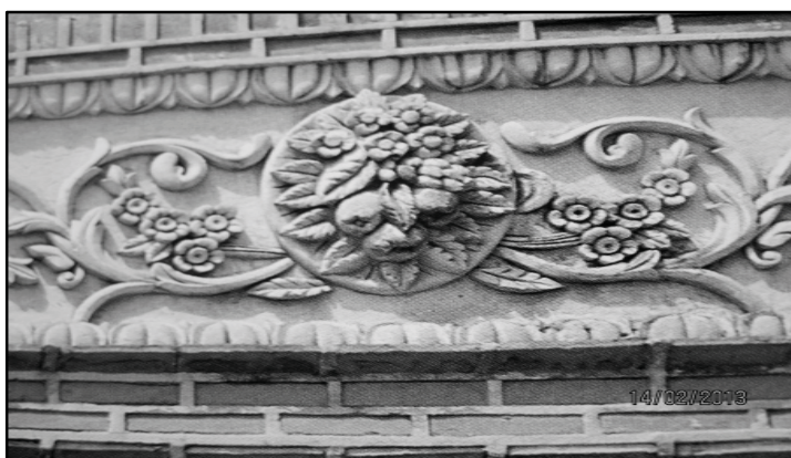
تصویر شماره ۳: گچ‌بری‌های بسیار درشت و برجسته و قالبی غربی که گچ‌بری ریز و دست‌پرورده‌ی سنتی را از دوره‌ی قاجار تحت‌الشعاع قرارداد (گوهر خیال، ۱۳۸۸)، ص ۹۹
